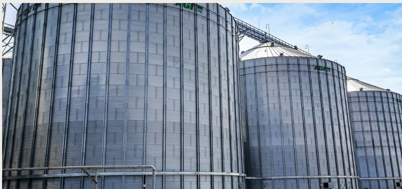
Silos a fondo piano. Fotografia: AGI.
