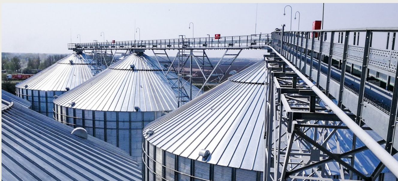
Pasarele și structuri de susținere. Fotografie AGI.
